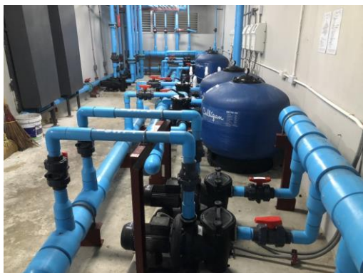
ภาพที่ 8 ระบบกรองสระว่ายน้ำ
