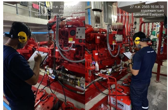
ภาพที่ 57 การจัดให้มีการทดสอบระบบและบำรุงรักษาระบบดับเพลิงให้พร้อมกับการใช้งาน
