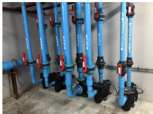
ภาพที่ 8 ระบบกรองสระว่ายน้ำ
