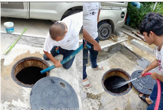
ภาพที่ 56 การดุดบ่อเกรอะ (วันที่ 13 ธันวาคม 2566)
